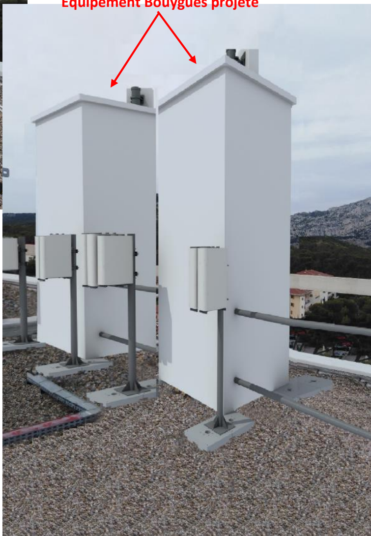
Equipement Bouygues projeté
