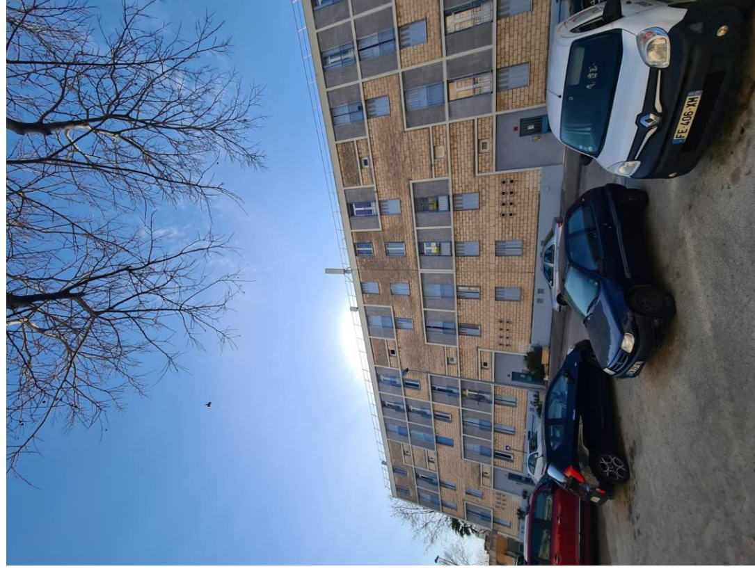
Photographies avant _Vue de loin
