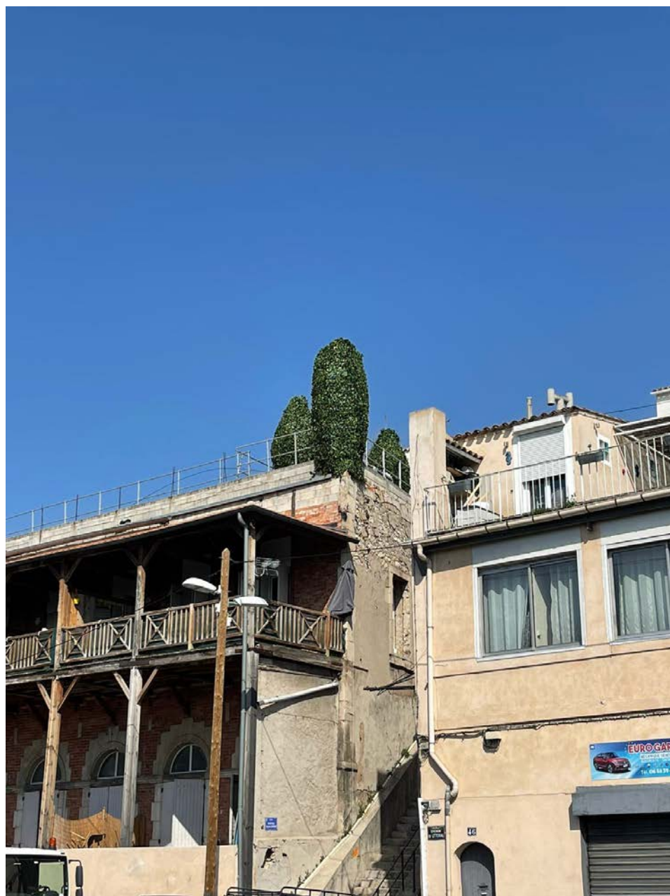
Photographie après travaux
