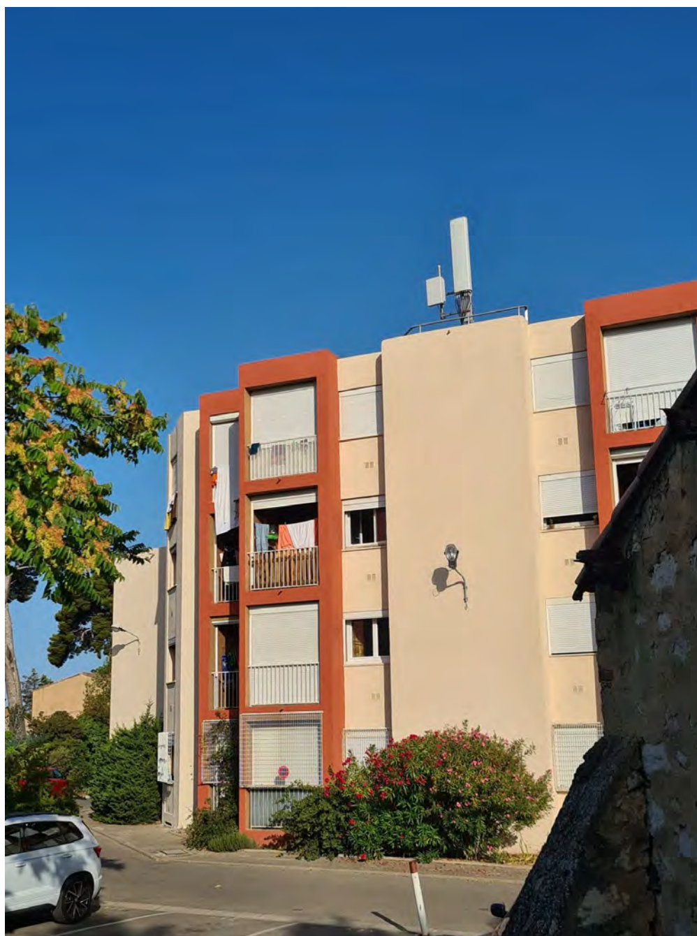
Photographie avant travaux secteur 2 (vue de loin)
