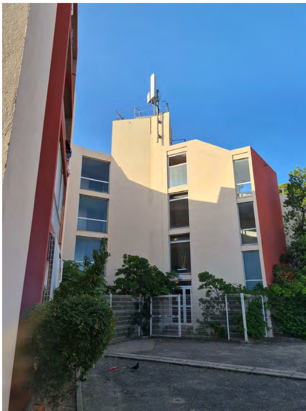
Photographie après travaux secteur 0 (vue de loin)
