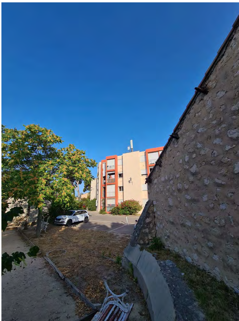
Photographie après travaux secteur 1 (vue de loin)
